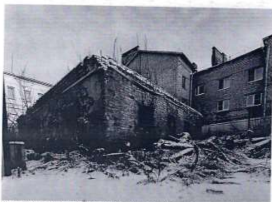
Вид на объект с юго-западной стороны. Сохранившиеся стены первого этажа с южной и западной сторон здания.
