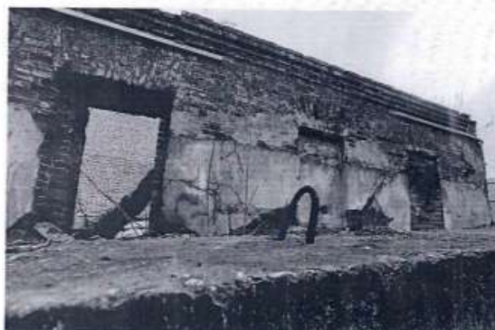
Вид на западную стену (на фото сохранившиеся: один дверной проем и два оконных проема)
