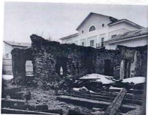
Вид с северной стороны на восточную часть здания. Многие внутренние стены первого этажа утрачены. В сохранившихся внутренних стенах первого этажа остались некоторые дверные проемы. Только в южной части здания сохранились сквозные перекрытия из кирпича.
