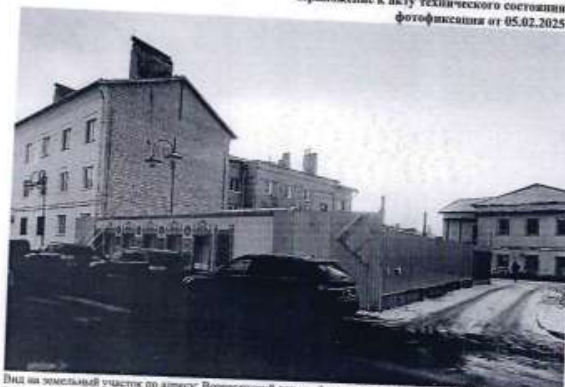
Приложение к акту технического состояния фотофиксация от 05.02.2025
